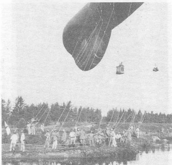
Övergång av Lagan i Skillinga- ryd. Transporttåget är överfört. Ballongen är här neddragen så att man även har kunnat fatta i manöverlinorna.
