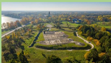
Tingstäde fästning stod klar lagom till första världskriget. På grusåsen ligger Skans 1 med sina många rum och långa underjordiska gångar under mer än meterdjup betong
